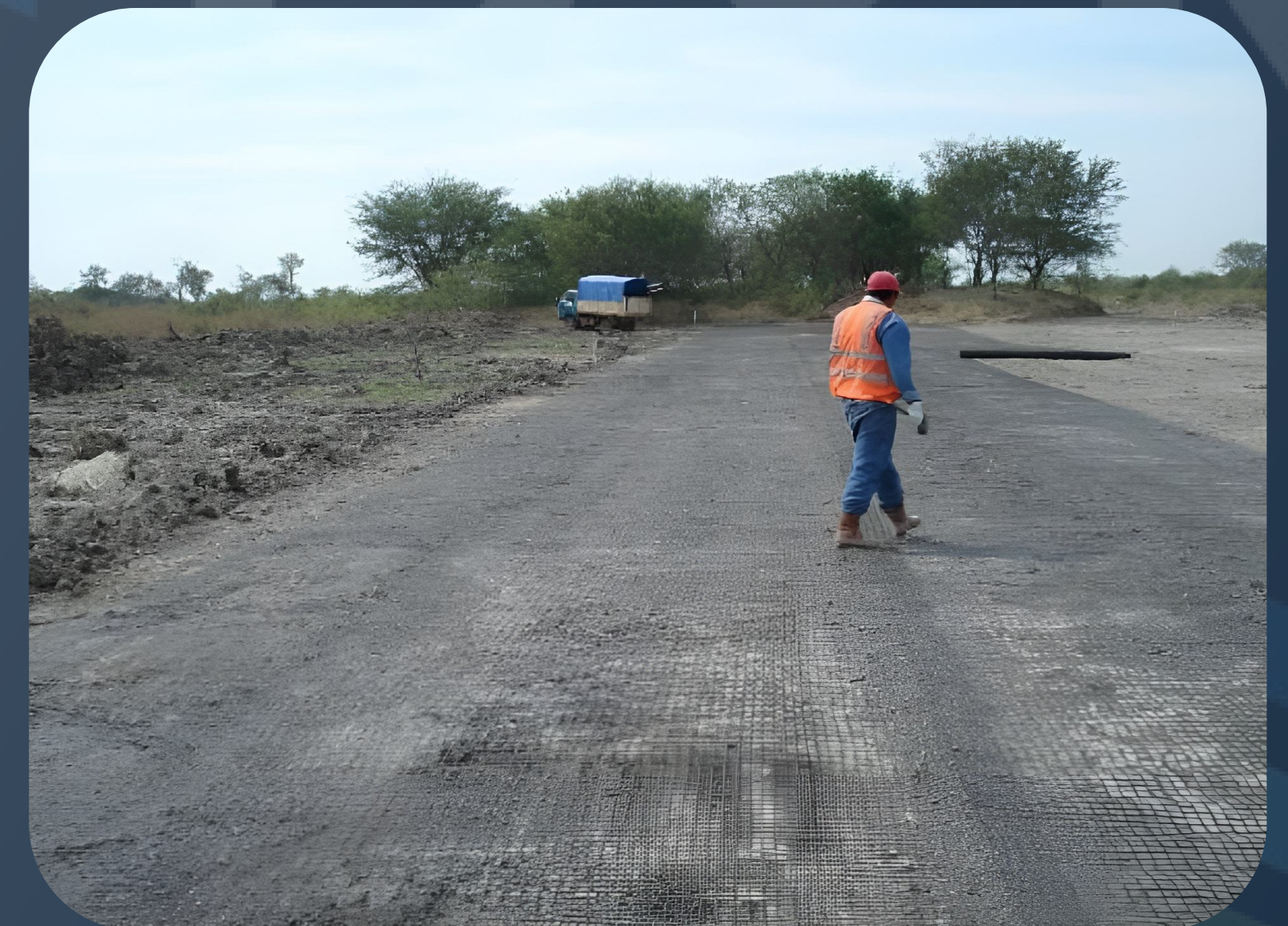
Carretera El Tinto – San José Estabilización de subrasante con geomalla Biaxial TENSAR Santa Cruz - 2012
